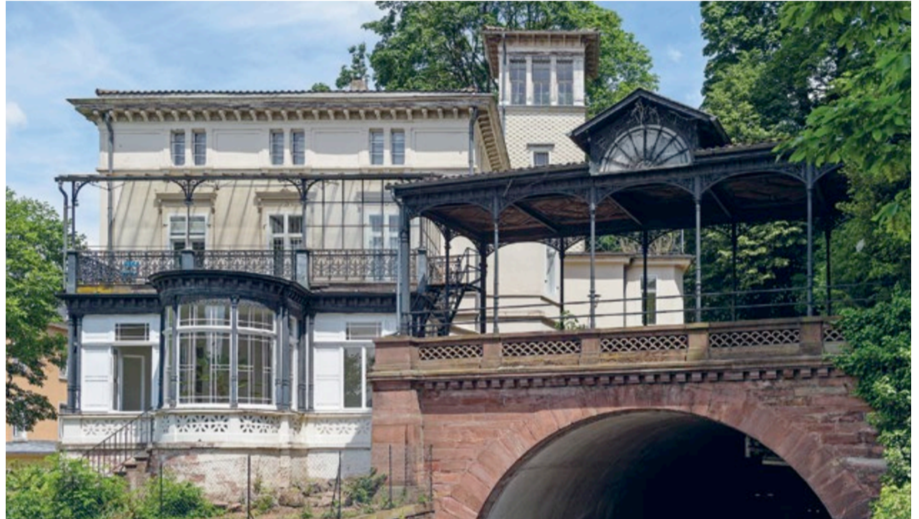
Die Villa Manesse befindet sich in der Friedrich-Ebert-Anlage 4 oberhalb des Gaisbergtunnels. Fotos: Rothe
