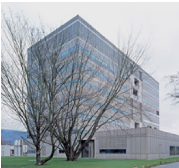
Im Neubau BIOQUANT ist auch der Exzellenzcluster „Cellular Networks“ untergebracht.
